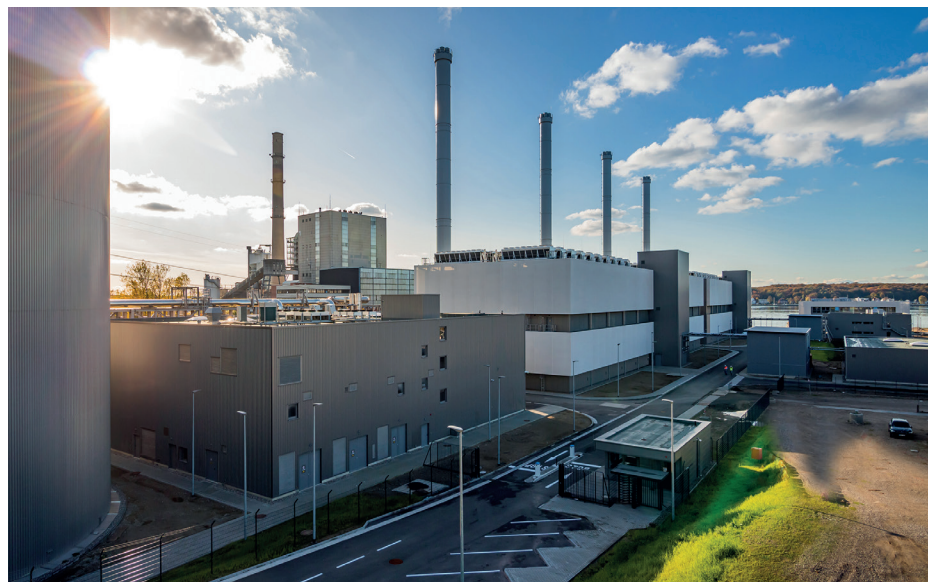
20 silników gazowych Jenbacher J920 Flextra to serce nadbrzeżnej elektrociepłowni, wytwarzającej 190 megawatów mocy elektrycznej dla niemieckiego miasta Kilonia. „Prawa autorskie do zdjęć: Stadtwerke Kiel”
