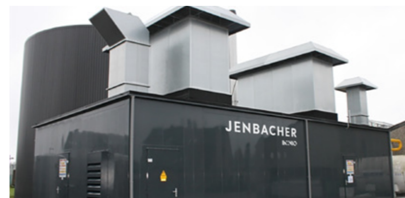
Soluzione CHP modulare Jenbacher per serre con isolamento acustico esterno
