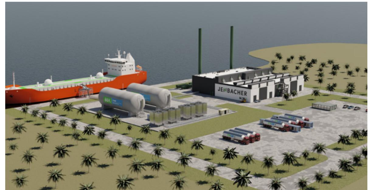
分布式发电厂发电功率通常在10MW-50MW范围内，颜巴赫单机电力输出250 kW-10.4 MW发电机组产品系列适合这个范围。发电机组尺寸紧凑并且结合INNIO的集装箱解决方案可以快速安装，可以轻松满足海上和小型岛屿安装条件。
