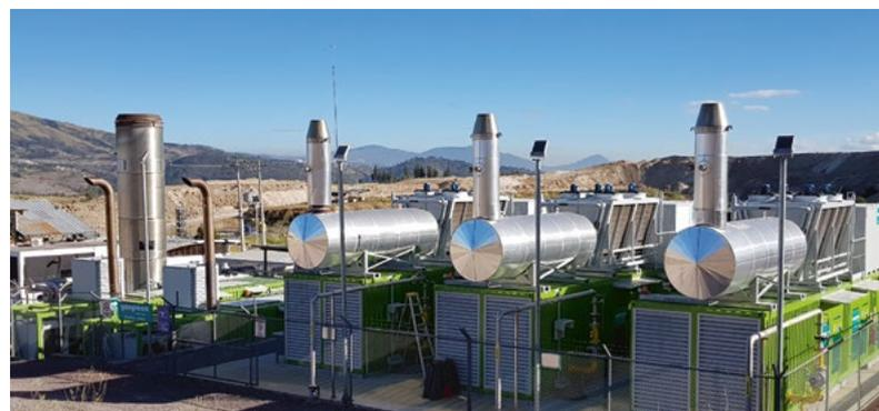
Los grupos electrógenos Jenbacher, diseñados, fabricados y empaquetados por AB Energy, se seleccionaron en función de la capacidad de generación demostrada y la eficiencia eléctrica a grandes altitudes, así como por su precio competitivo y la extensa base instalada en vertederos de todo el mundo. El proyecto se completó a tiempo según el cronograma establecido por Gasgreen.
